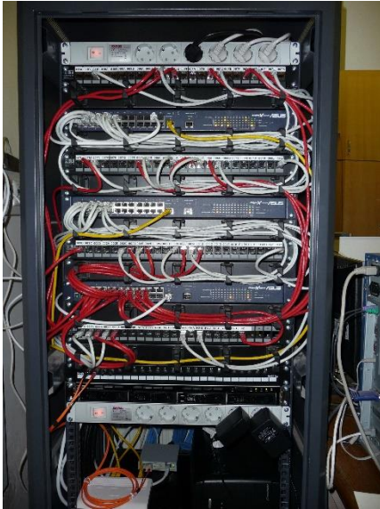
30. ábra: Rack szekrény hálózati eszközökkel Kép forrása: http://lvnetwork.hu/index02.html Letöltés dátuma: 2018. 11. 28.
