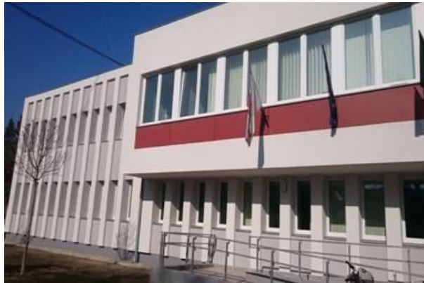
30. ábra: Zalaszentgróti Járási Hivatal épülete a felújítás után 2017-ben (Forrás: Kormányhivatal által közzétett kép 2017-ből)
