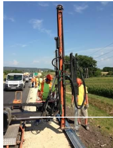
5. ábra- Szalagkorlátverő gép ( roadpiktor.hu )
