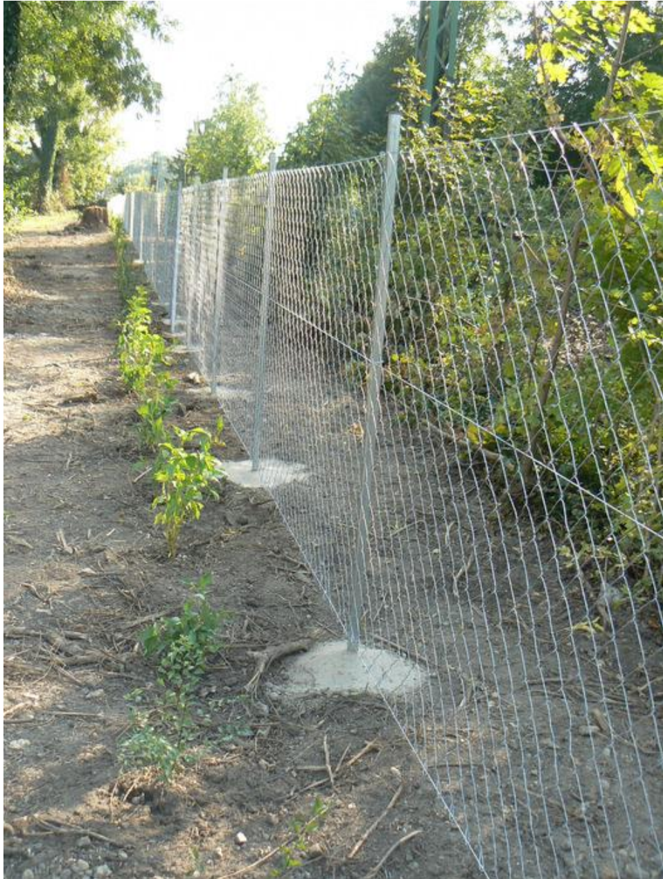
5. Kerítés építése, cserje ültetése
