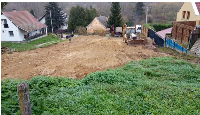
14. ábra Lakóépület bontás után
